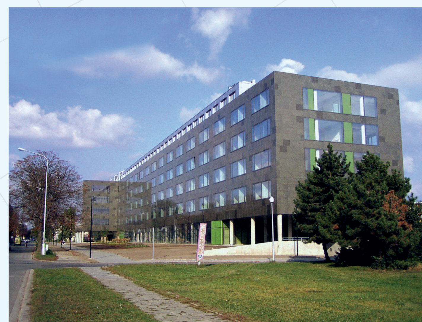
Katedra geografie patří mezi ta pracoviště Přírodovědecké fakulty UP, která v roce 2009 mění adresu stěhováním do nové budovy na třídě 17. listopadu. Slavnostní otevření budovy proběhne 22. června 2009.
