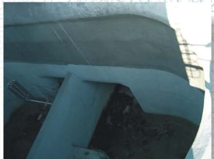
Fot. nr 11. Wnętrze wieży przelewowej - widok na sztolnie
