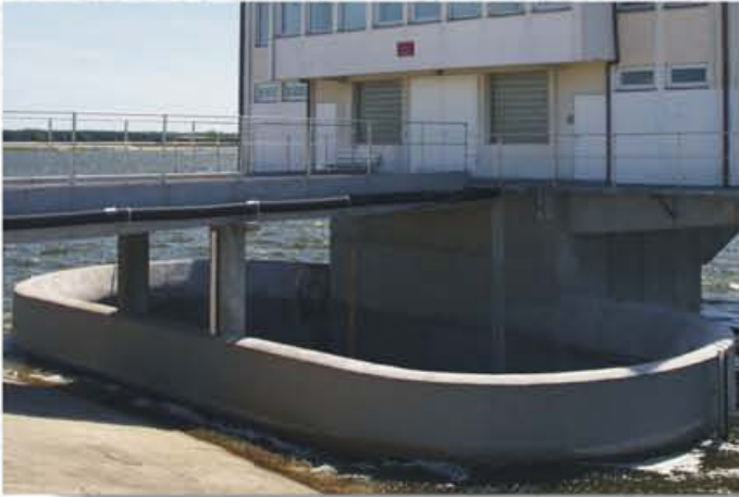
Fot. nr 10. Wieża przelewowa
