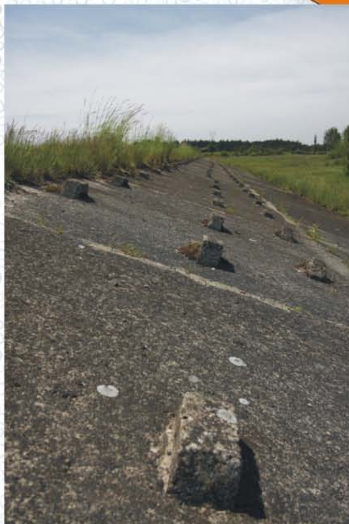
Fot. nr 14. Umocnienie skarpy odwodnej
