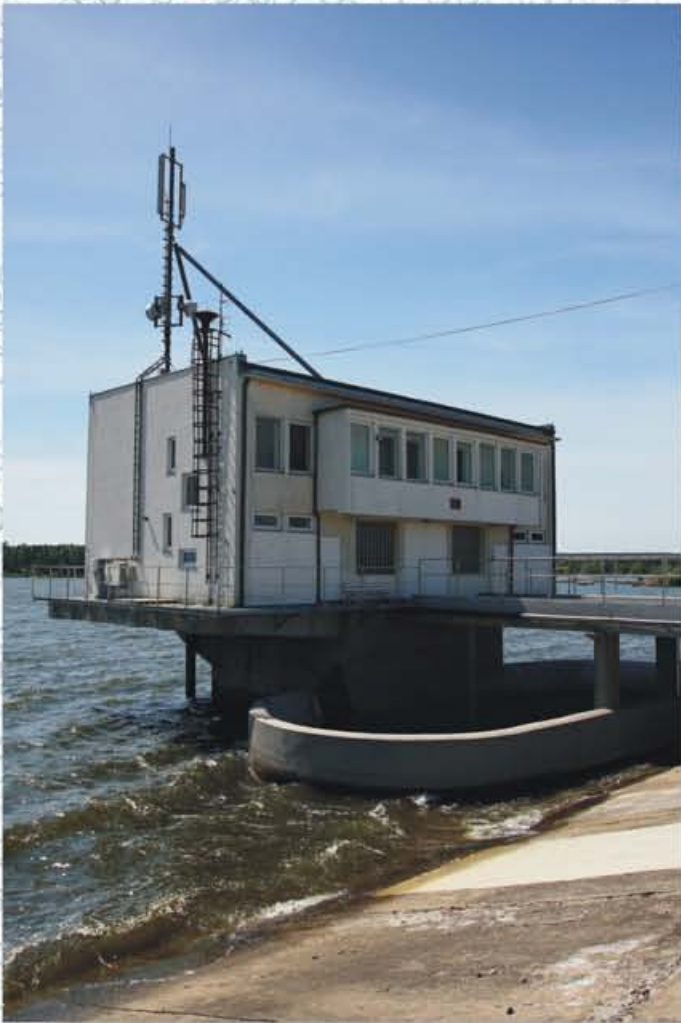
Fot. nr 4. Sterownia wraz z wieżą przelewową
