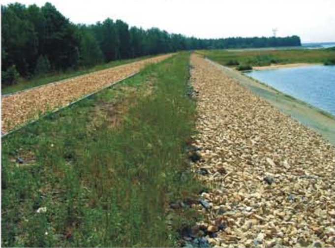
Fot. nr 12. Widok na zapórę boczną nr 1
