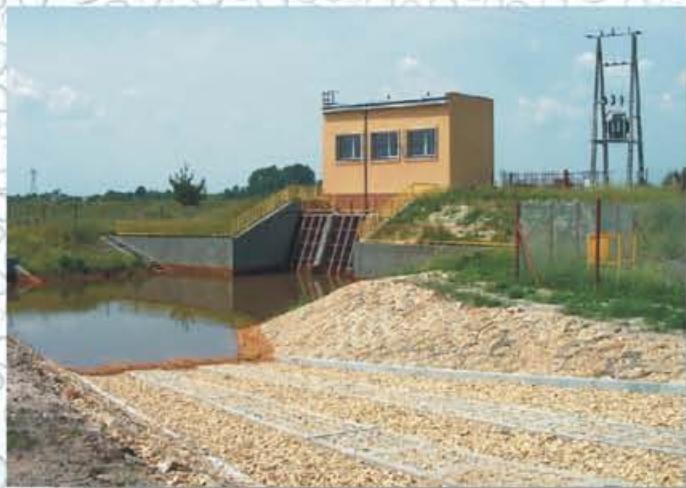
Fot. nr 17. Pompownia nr 2 - widok od strony zbiornika wyrównawczego
