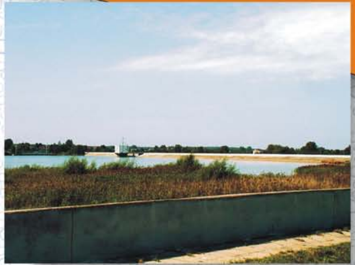
Fot. nr 3. Widok na zapórę czołową wraz ze sterownią
