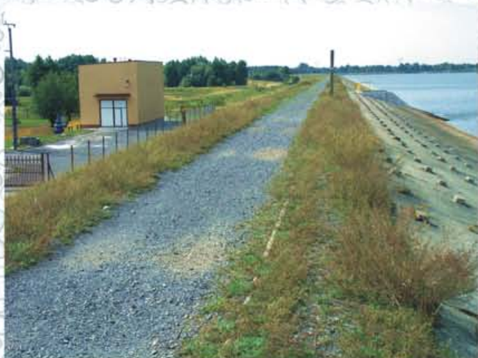
Fot. nr 13. Widok na zaporę boczną nr 2 oraz budynek pompowni nr 1
