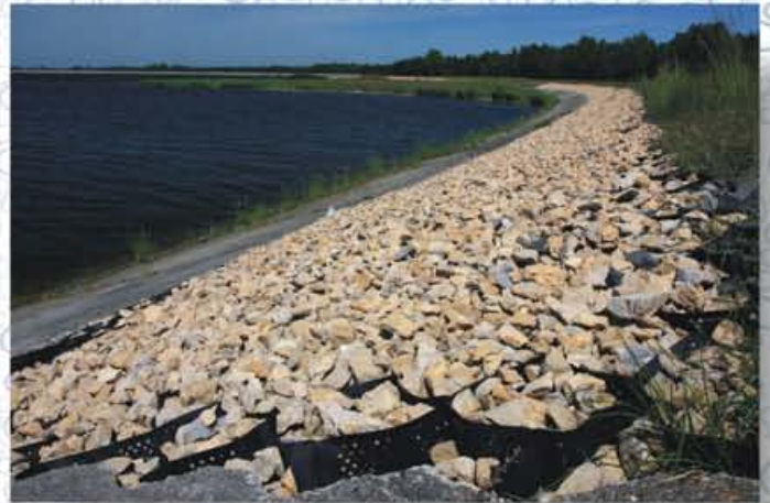
Fot. nr 6. Brzeg umocniony z zastosowaniem tzw. geokraty oraz narzutu kamiennego
