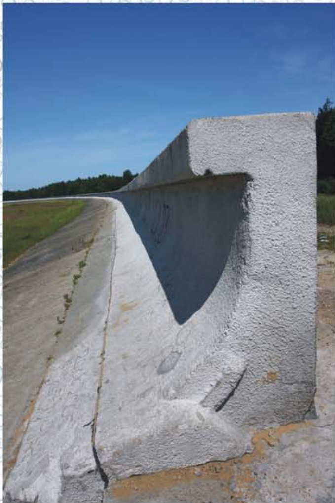
Fot. nr 8. Falochron żelbetowy
