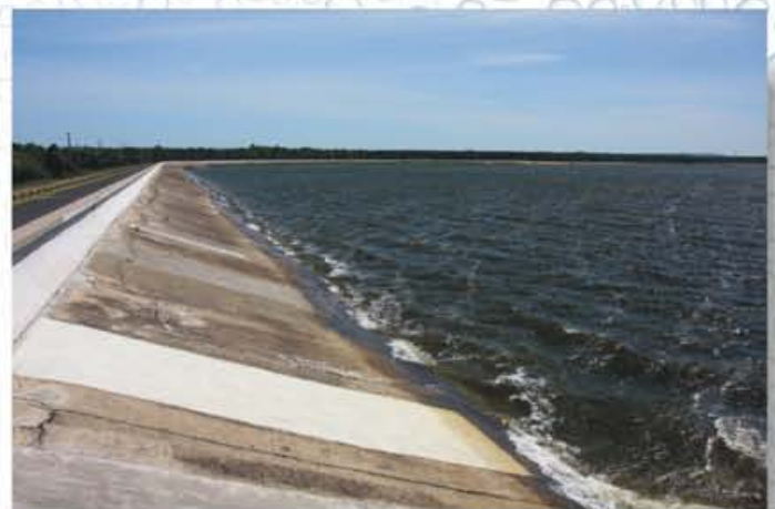
Fot. nr 7. Widok od strony sterowni na zaporę czołową - widoczny ekran z płyt żelbetowych
