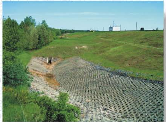
Fot. nr 9. Widok na skarpę odpowietrzną zapory czołowej z rowem drenażowym (w tle powyżej korony zapory - budynek sterowni)
