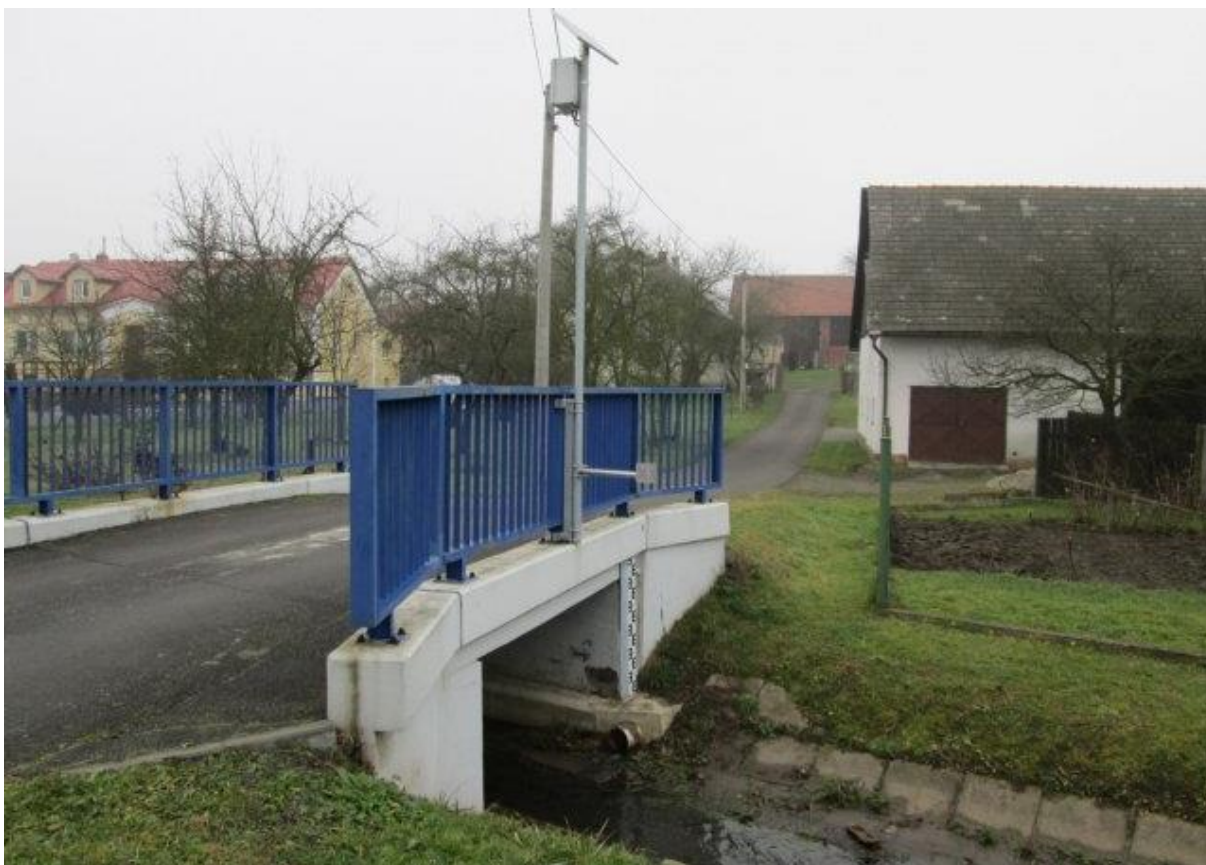
Obr. 15: Hladinoměr na řece Teplá a zpevněné koryto Zdroj: vlastní foto
