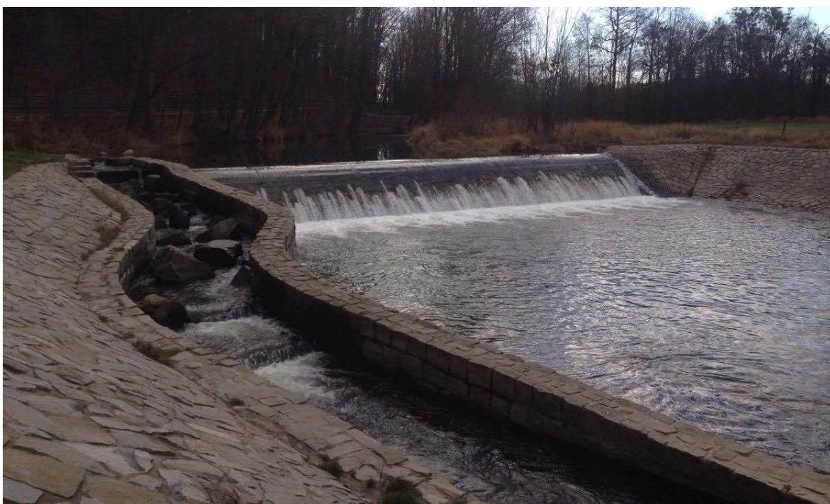
Obr. 12: Jez na řece Odře Zdroj: vlastní foto
