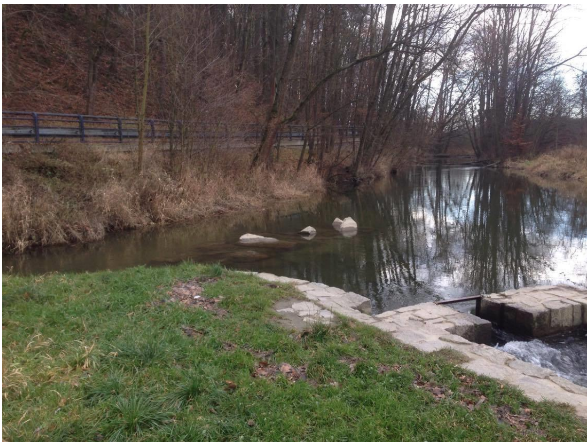
Obr. 13: Náhon k lesnímu mlýnu Zdroj: vlastní foto
